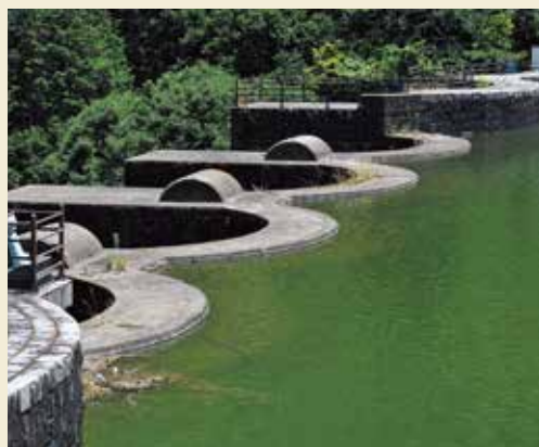
縦長5基のアーチダムが肩を並べるようにダム湖の湖水を押さええている。アーチを支える扶壁には増水した貯水を排水するサイフォン式の洪水吐が設けられており満水近くなると自動的に放流する。この構造を含め当時の画期的な土木技術が評価され豊稔池堰堤は2006年、国の重要文化財に指定された
