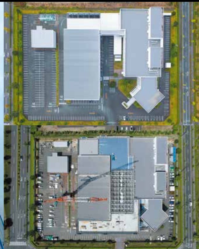
上/着工前の既存棟配置 下/屋根トラス架設時状況(提供:東洋建設(株))
