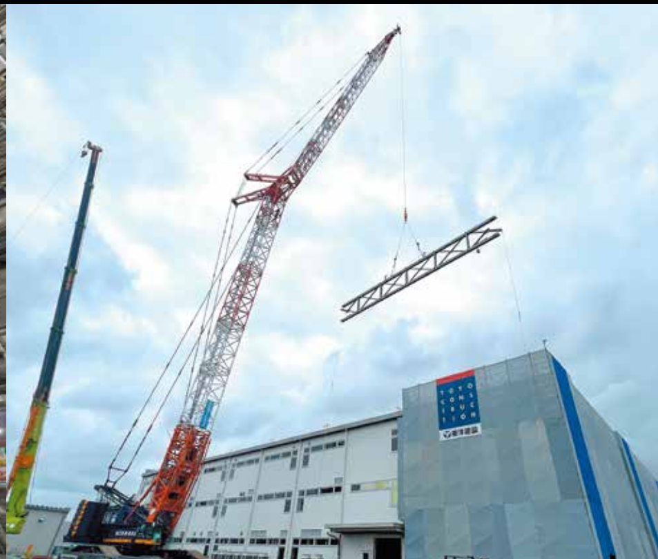
クローラークレーンによる大屋根架設状況。地組したトラスをユニットごとに架設(提供:東洋建設(株))
