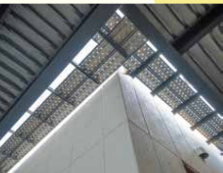
新旧2棟の縁切り部分。既存建物との離隔に配慮しながらの建築で培われるノウハウもある
