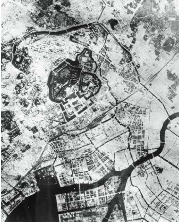
空襲で破壊された東京都、皇居周辺の様子。白い部分は被災したことを示している（提供：昭和館）
