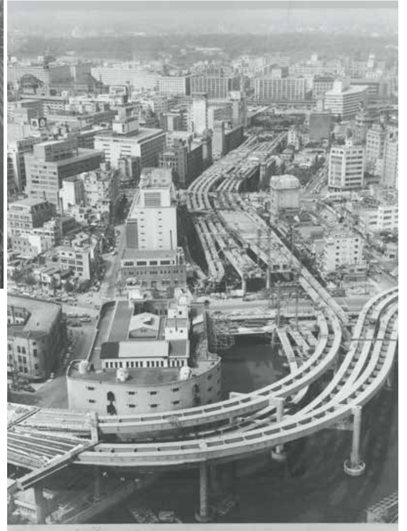
建設が進む首都高速道路1号線(提供：東京都)
