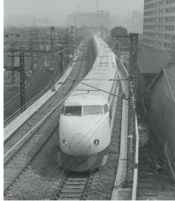
開通にそなえ試運転する東海道新幹線(提供：東京都)
