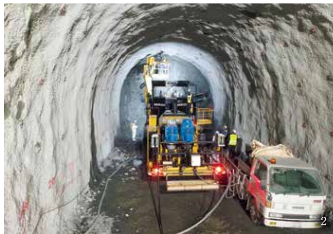
1. 新日下川放水路工事完成式典 2. ロックボルト専用機を使用した打設状況 3. 機械改良型スリップフォーム工法によるインバート打設状況
