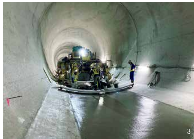
1. 新日下川放水路工事完成式典 2. ロックボルト専用機を使用した打設状況 3. 機械改良型スリップフォーム工法によるインバート打設状況
