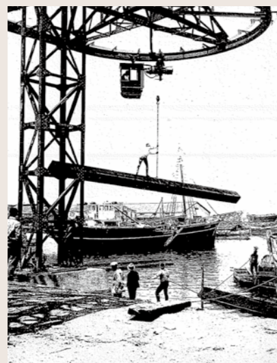
テルファーには運転室がつき、オペレーターの指令で接岸する貨物船の積荷を直接吊り上げ、レールを移動し貨物列車に降ろす仕組みになっている。役目を終えた今もなお、水運と陸運をつないだ主要施設の姿を今に伝えている(出典:『清水港開港100年史』)
