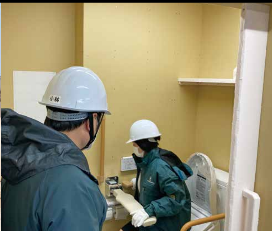
先行モックアップを体験する施設管理者。利用者の利便性を細かく確認する。
