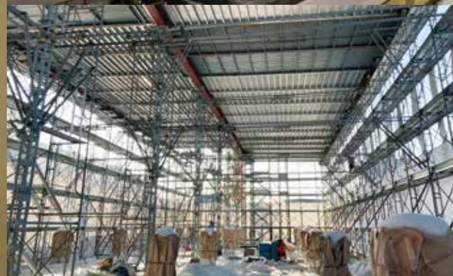
工事は短冊のように細長い現場の限られたスペースで検証を繰り返しながら進行。周辺の住宅や駐車場への上屋の除雪作業にも対応した。
