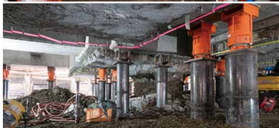
仮受設備と水平拘束に支えられている旧庁舎の基礎部。宙に浮いたような状態だが強固かつ柔軟に建造物を支持している。今後、この基礎部に順次免震装置を設置していく。
