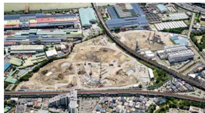
阪神本線と阪神なんば線に囲まれた小田南公園で新球場の建設が進んでいる。(提供: ㈱熊谷組)
