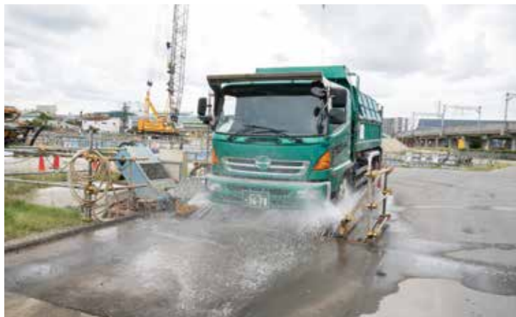
現場では工事車両のアイドリングストップや入退場時の洗浄、リサイクルを目的とした廃材の分別、水道の使用を抑制する井戸水の活用など、できることはすべて展開していると遠藤所長は話す。
