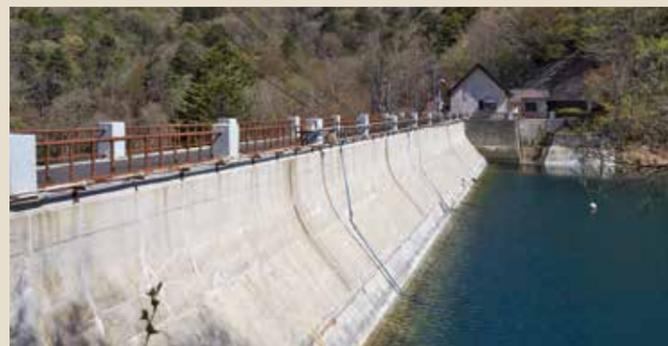
上流側の遮水壁も再塗装され健全性を保っている。この左手、下流側で巨大なジャングルジムのようなバットレスが遮水壁にかかるダム湖の水圧を支えている。バットレスダムはコンクリートを節約できる利点がある一方で設計、施工に極めて高度な技術を要することから採算が合わず、1937年を最後に新設されたものはない。
