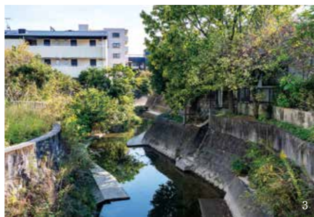
1. 二次覆工の完了時 2. 全長の短いシールド機 3. 地上部の高尾川
