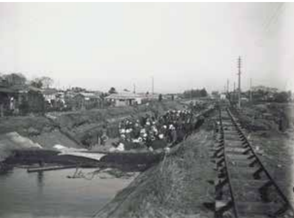
1921年に発生した地震からの水路復旧の様子。全市断水と付近一帯の洪水が生じたことにより、大規模な復旧工事が展開された。(提供：東京都水道歴史館)
