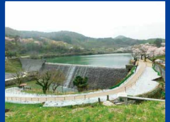
堤体自体の重さで水圧を受け止める構造物であるダム。その概念を覆す「アンカー工法」で補強が行われた千本ダム。100年以上前につくられたダムとして、登録有形文化財にも指定されている歴史的建造物を国内初の工法で補強したプロジェクト。松江市の水道用水の約1/4を供給する重要な施設の耐震補強工事への挑戦を追う。
