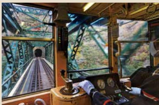
早川橋梁には斜材がX状に配置されたダブルワーレントラスが採用されている。斜材が交差するポイントを連結することにより橋の強度が増し、細い鋼材で構成することができる。一方でより多くの資材が必要となることから技術の進歩とともに大正期以降は減少した。
