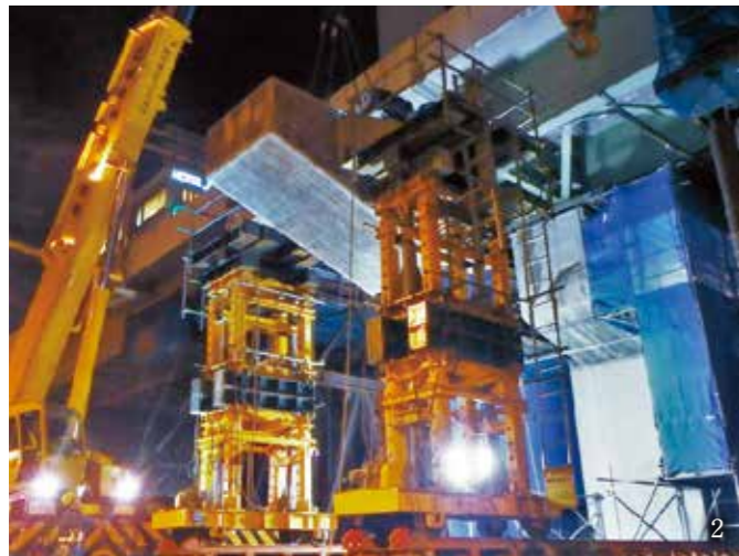
1. 渡り線、拡幅部 2. 既設橋脚撤去の様子 3. 再構築された橋脚
