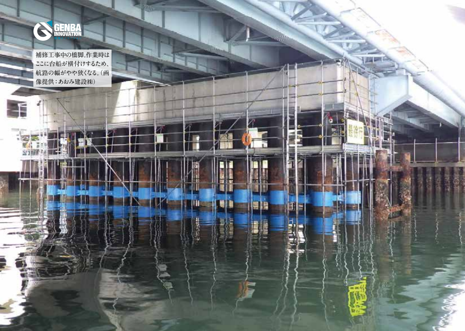
羽田側の鋼管杭(未施工)。ここはコンクリートの足場があるため、水面より上の補修作業はドライな環境で行えるというメリットがある。
