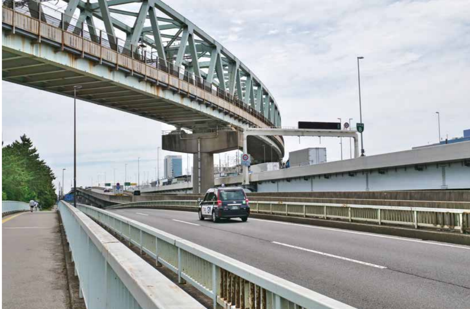
国道357号線の頭上にJR京葉線の高架が通る。
