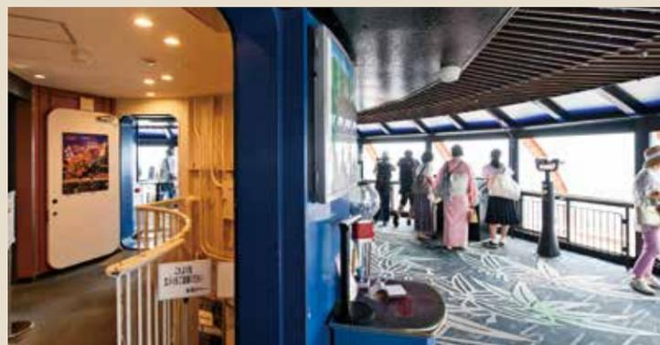
地下3階地上9階のビルの上に高さ100mのタワーが載るというユニークな構造を持つ。全体の高さは131m。タワー部分は、鋼板によるモノコック構造を採用することで高強度を確保すると同時に軽量化(800t)も実現した。地上100mの展望室からは、京都三山に囲まれた京都市街地が360度見渡せる。写真は塔身内部から見たモノコック構造の断面。
