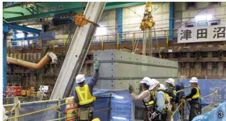
1. 立坑掘削状況（開閉式屋根を設けた防音ハウス上部からの残土搬出） 2. 鋼製セグメント函体組立状況（切羽側から5リングが完了した状況） 3. 鋼製セグメント函体組立状況（上床版のピース取付状況）
