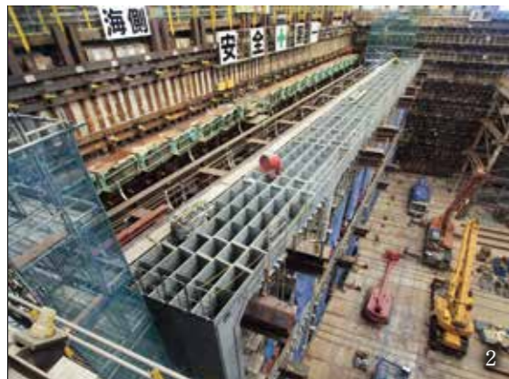
1. 立坑掘削状況（開閉式屋根を設けた防音ハウス上部からの残土搬出） 2. 鋼製セグメント函体組立状況（切羽側から5リングが完了した状況） 3. 鋼製セグメント函体組立状況（上床版のピース取付状況）
