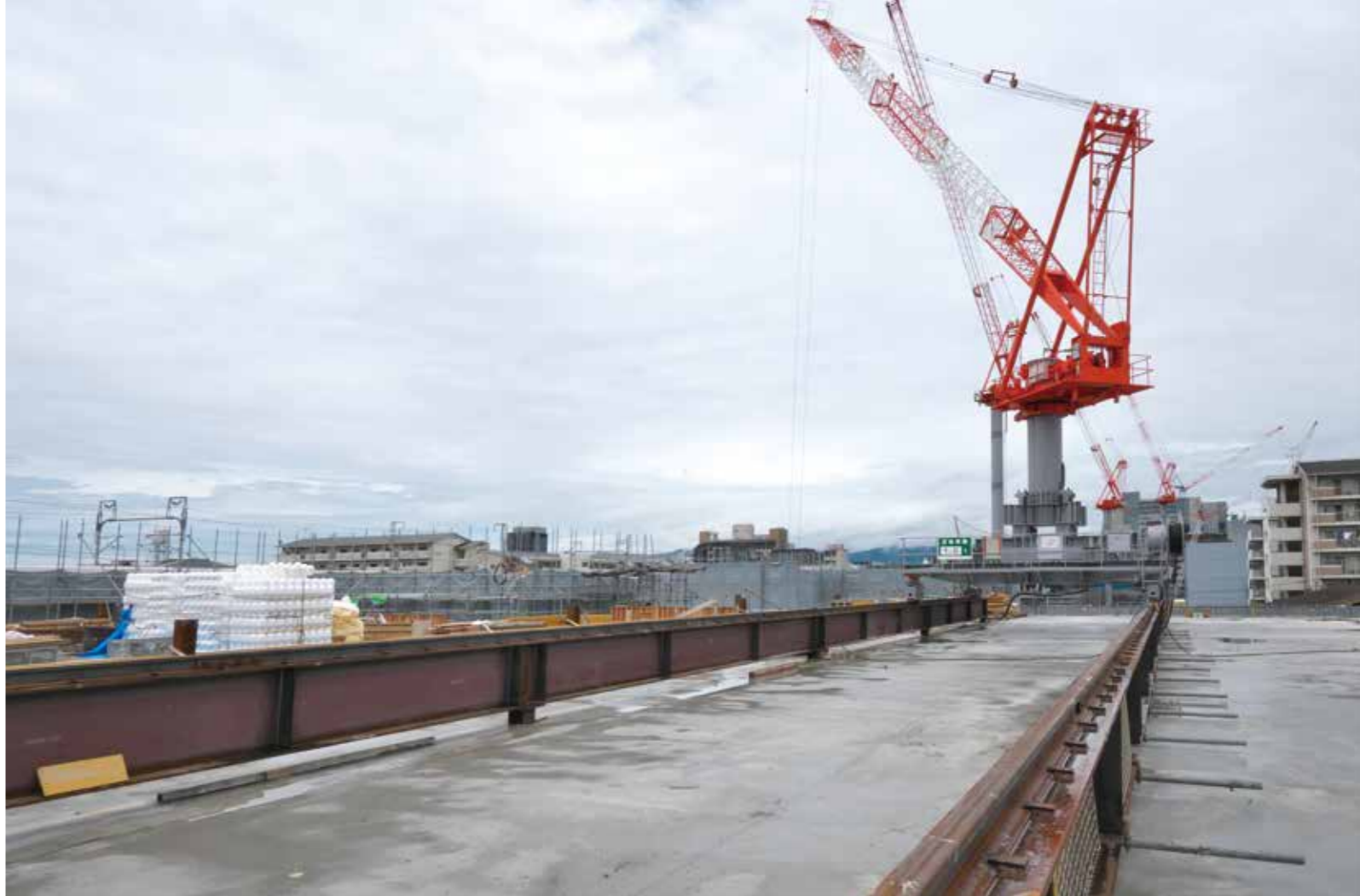
鉄骨鉄筋コンクリート造の大学施設の屋根に設置されたレール走行式ジブクレーン。敷地奥部への資材揚重や鉄骨建方に活躍している。
