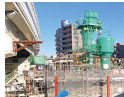
ニューマチックケーソン工法で施工中の到達立坑。首都高速道路の高架橋との近接工事であることがよくわかる。(画像提供：株安藤・間)
