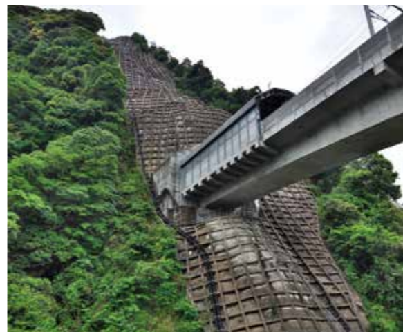
垂直に近い法面。施工した面積は4,800㎡にもおよんだ。
