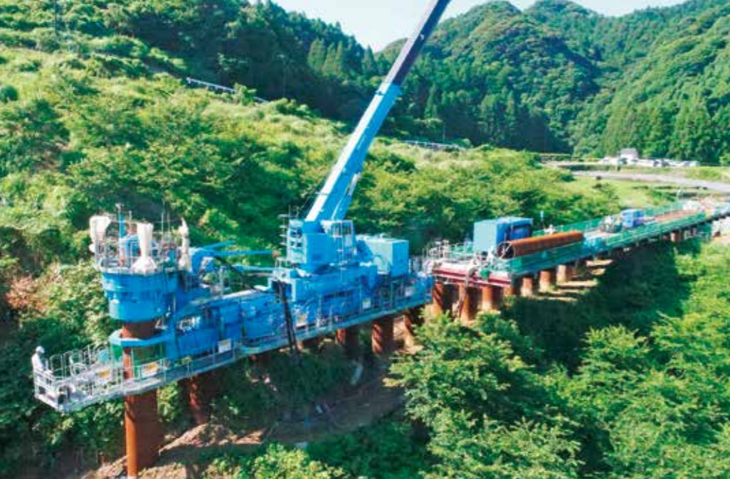
地滑り抑止杭打設の様子(提供:鹿島建設株)
