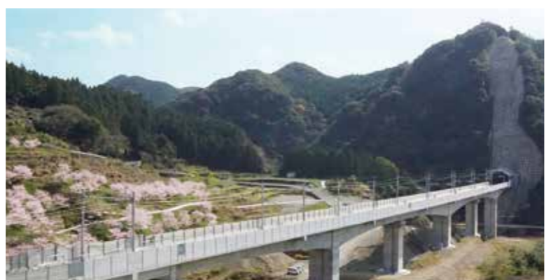
完成した彼杵川橋梁と三ノ瀬トンネル坑口。植樹された桜が新幹線を迎える。(提供:鹿島建設株)
