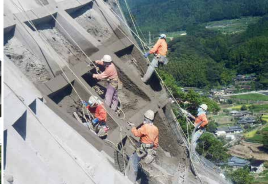
協力会社の技能者はオレンジ色に統一されたユニフォームで現場に挑んだ。「遠目にも一目で技能者の配置が把握できます。技術の追求だけでなくこうしたプロ意識の高さによって無事故で完成できたと思います」(鹿狹所長)(提供:鹿島建設株)
