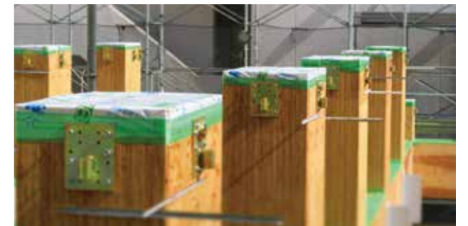
上/工場生産された十字部 下/雨を直接受ける上面にはシリコンシーリングをすり込み、養生フィルムを貼って、次工程まで吸湿・吸水を完璧に防ぐ。
