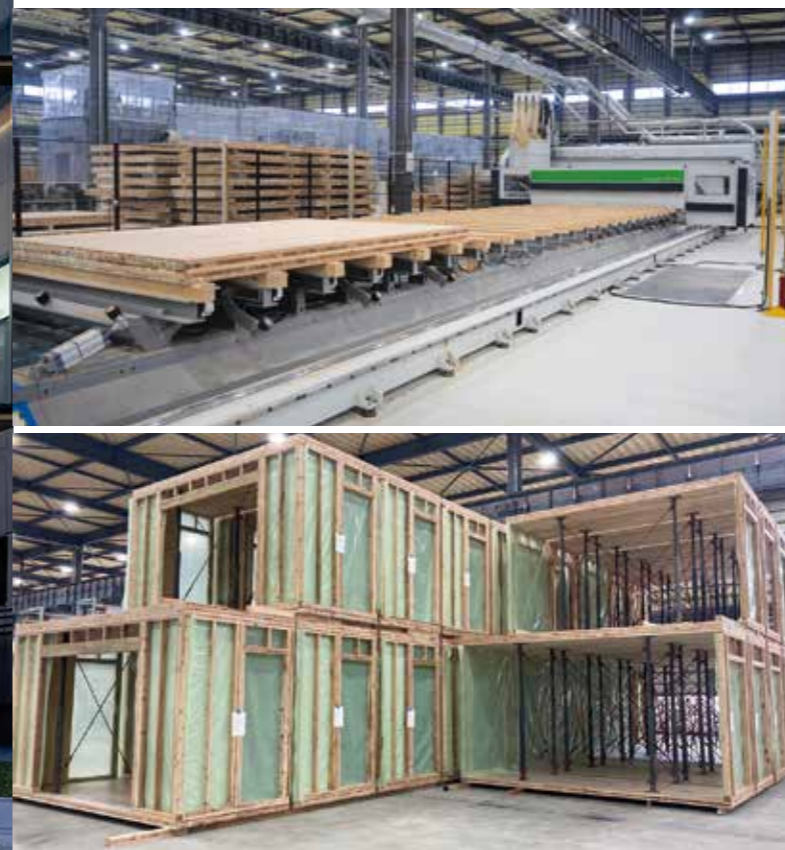
上/工場でのCLT材の製造、加工の様子 下/木造ユニット建物に使われるユニット(いずれも提供：MEC Industry株)
