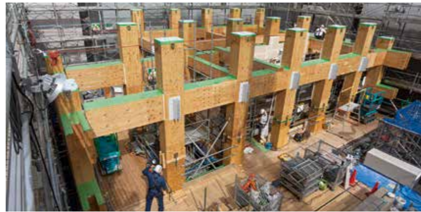
施工中の様子。東西方向に十字部が並べられ、柱・梁部でジョイントされていく。
