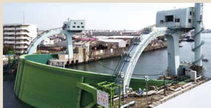
2018年に閉門した際の映像をWebで見ることができる。20秒ほどの動画だが水門に隔てられた上流と下流の水位差は3mを超えているように見える。整備された当時は津波被害に対する意識は希薄だった。東日本大震災を機にこの津波対策が視野に入る。水門は今後約20年の歳月をかけて生まれ変わることになる。
