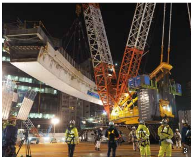
1. 迂回路を構築し、高架下空間を工事用動線として活用した 2. 供用中の道路の間にある現場で圧入機を配置する様子 3. 大井ジャンクションで大ブロックを撤去する様子 4. 環境への配慮として透光型遮音壁を採用し、騒音や圧迫感を軽減した
