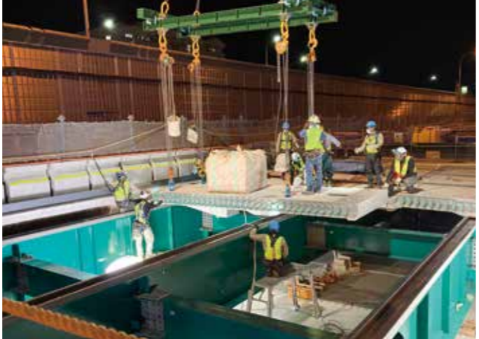
上／中国自動車道の現場での床版設置状況（画像提供：三井住友建設株） 左／鉄筋の交点を結束する「ロボタラスII」。「先端についている結束機は、市販されているものと同じです」（竹之井課長）
