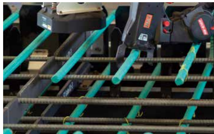
上／中国自動車道の現場での床版設置状況（画像提供：三井住友建設株） 左／鉄筋の交点を結束する「ロボタラスII」。「先端についている結束機は、市販されているものと同じです」（竹之井課長）
