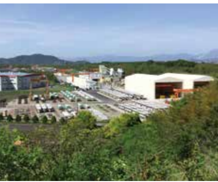
能登川工場全景。場内にはコンクリートのプラントもある。(画像提供: 三井住友建設(株))
