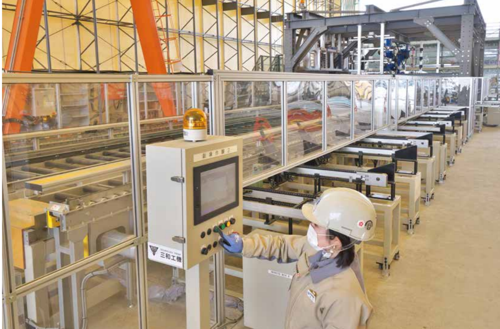
「ロボタラスII」の操作盤。使用する鉄筋を所定の位置にセット後、ボタンを押せばほとんどの作業を全自動で行う。
