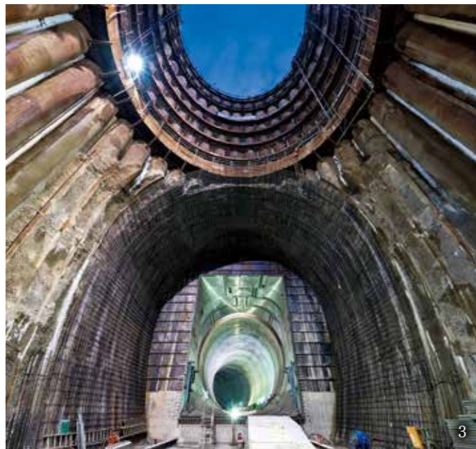
1. 呑口立坑施工状況を上空より望む 2. 呑口立坑部の鋼管矢板建込みが完了した様子 3. 呑口立坑下部より、トンネル貫通部と立坑上部を望む 4. 減勢工ヤードで組み立てた水圧鉄管を坑内へ引き込んでいる様子
