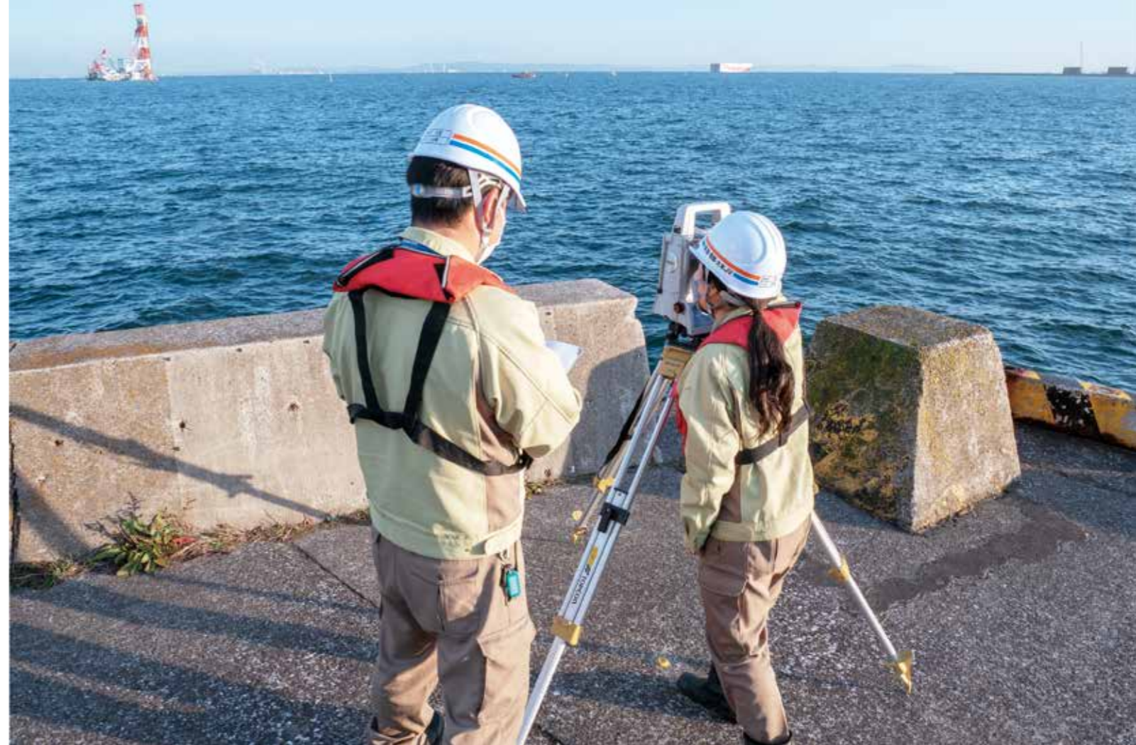
施工箇所から最も近い陸地からの測量。写真左上の作業船付近が施工箇所、距離的にはこの測量機器で計測できる限界に近いという。
