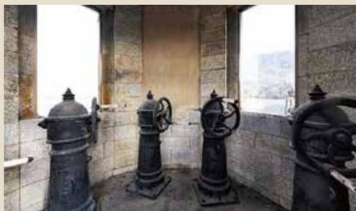
堤体は御影石の布積み、12m間隔で設けられた堤体を保持する縦帯、高欄部分が外側に張り出すように積み上げられた堤頂部の構造など、機能性と美観が見事に調和する意匠が目目を引く。堰堤をはじめ丸井戸、第一量水井、階段などを含め国の重要文化財に指定された。鑄鉄製の配管、仕切弁なども残されており当時の土木技術の粋を今に伝えている。
