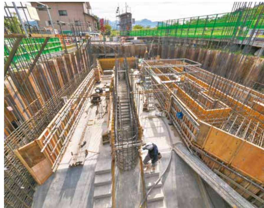
ポンプ場を支える堅牢な基礎部を構築するべく、現場での施工が進む。
