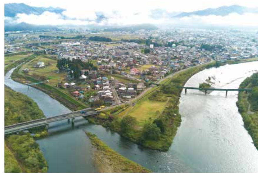
上／現場は魚野川と破間川の合流地点に位置する。2011年の洪水時には、付近一帯で床上浸水72戸、床下浸水180戸の被害が発生した。(魚沼市提供資料を基に作成) 下／魚野川下流側から撮影した付近の様子。
