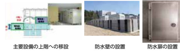
主要設備の上階への移設 防水壁の設置 防水扉の設置
