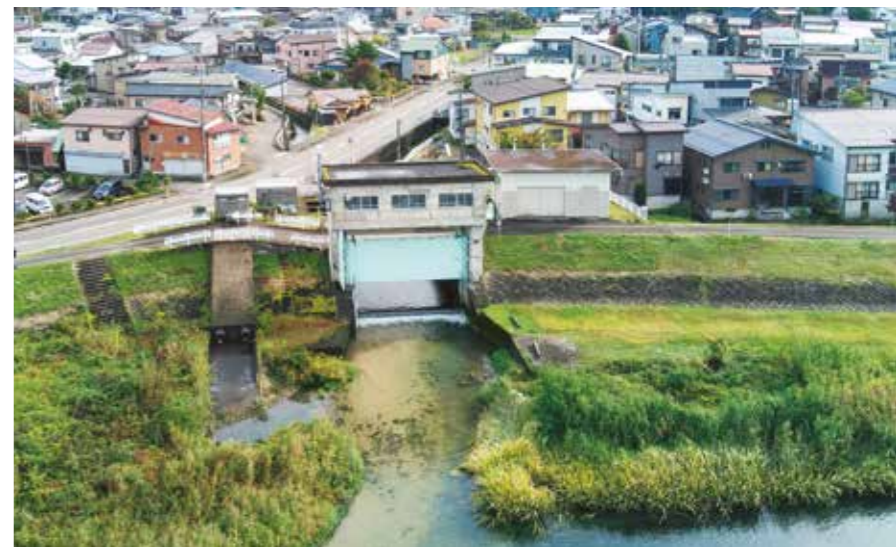
2011年の新潟・福島豪雨時に魚野川の水位は計画高水位ギリギリまで上昇した。上流側の排水機場の水門ゲートを閉鎖し、ポンプ排水も行われたが、豪雨のエネルギーはその処理能力を上回るものだった。
