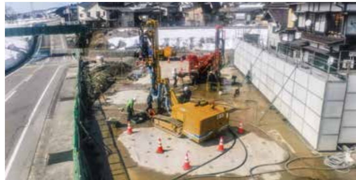
バーカッションドリルで先行削孔し、砂に置き換えた後、薬液を注入して強固な地盤を構築した。(提供：株植木組)
