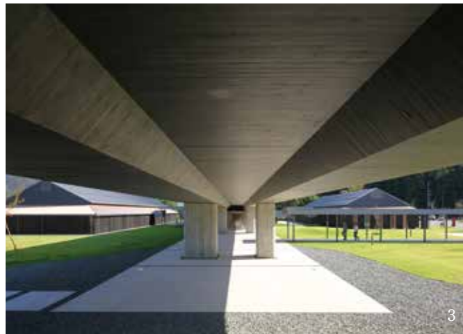
1. 丘よりカフェと展示室を望む 2. 年縞「現物」展示室「水月湖年縞7万年ギャラリー」 3. ピロティ（RC打ち放し、スギ板型枠）
