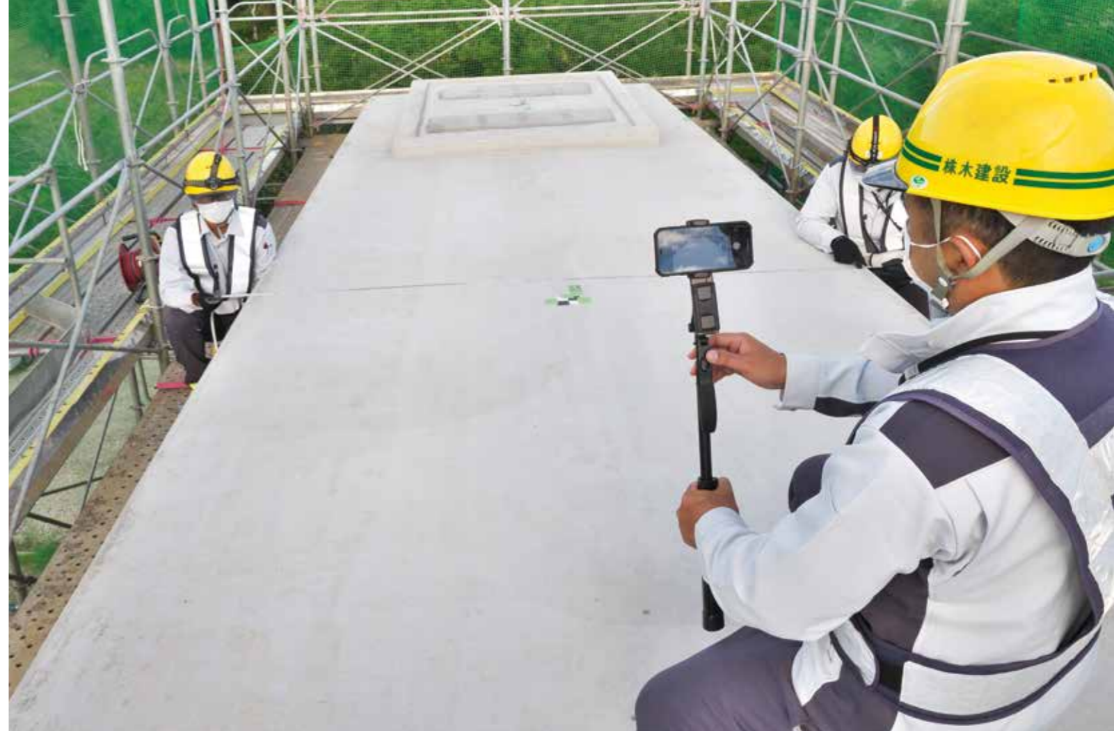
橋脚上での遠隔臨場の様子。スマートフォンを自撮り棒に装着し、足場など離れた場所からも撮影できるようにしている。
