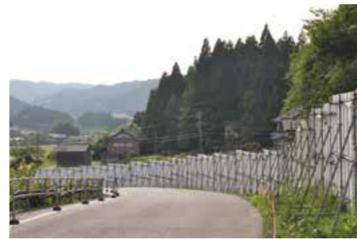
近隣の住民に施工音に対するヒアリングを繰り返し行い、防音パネルで現場を包囲するなどの対策を練った。
