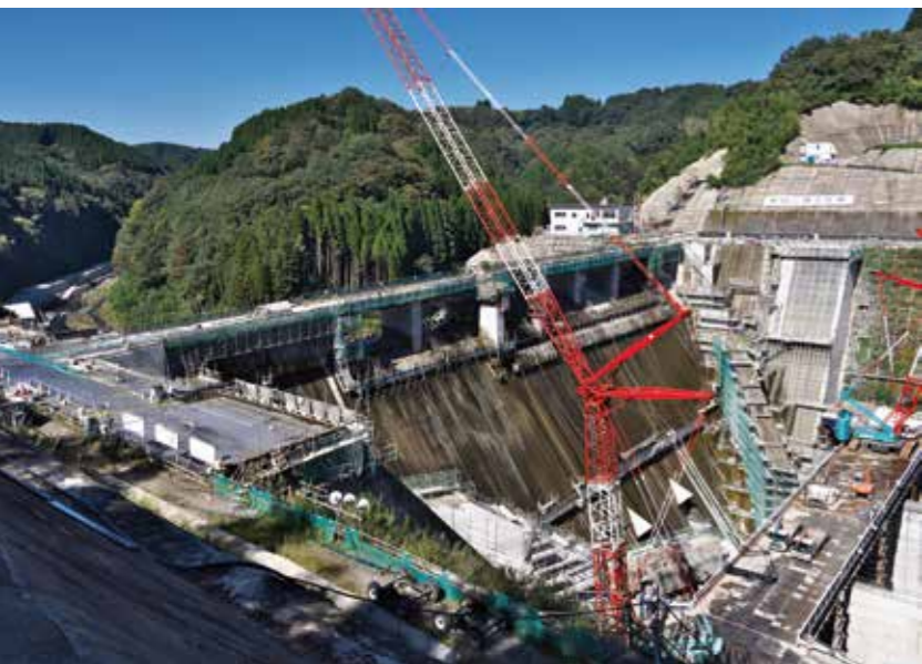
左／両岸の法面に見えるのが国内最大級の造成アバットメント。 上／造成アバットメントの概念図。軟質部を覆うように造成し、上下の堅岩部と一体化を図る。(提供：大分県)
