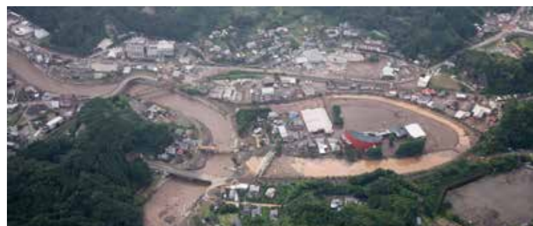
2012年7月、九州北部豪雨の際の出水状況。(提供：大分県)
