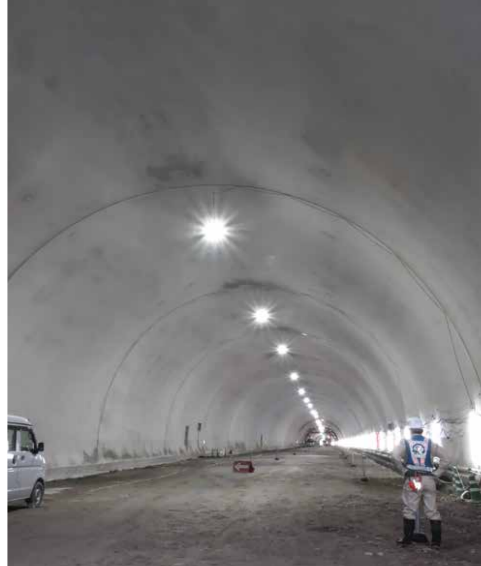
鷹ノ巣山2号トンネル(仮称)内部の様子。取材時(2021年10月上旬)にはコンクリート打設がほぼ完了していた。
