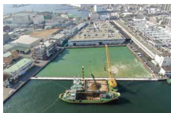
ケーソンで仕切られた部分が当現場の施工範囲(提供: 東洋建設株)
