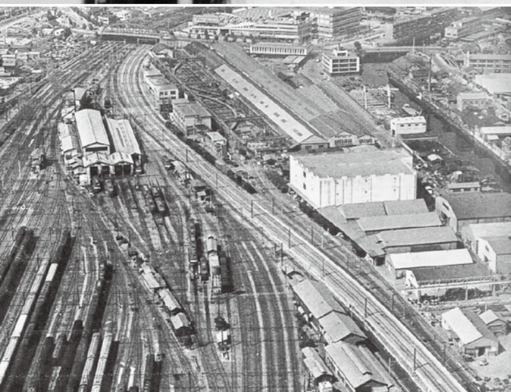
当時の品川駅付近の様子。写真中央から右下に、新幹線の線路が延びる。(提供:鉄建建設株)
