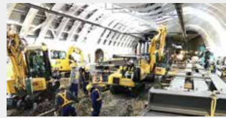
渋谷駅にて、銀座線のホームを既設の場所より130m移動して新設した。(いずれも提供：東京地下鉄株)
