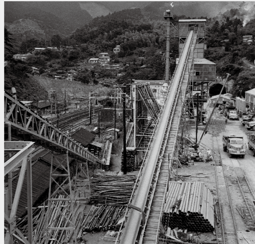
新丹那トンネル熱海口での施工の様子(提供:鉄道博物館)
