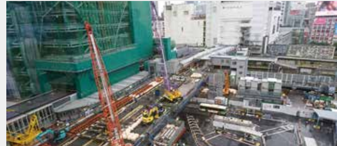
渋谷駅にて、銀座線のホームを既設の場所より130m移動して新設した。(いずれも提供：東京地下鉄株)
