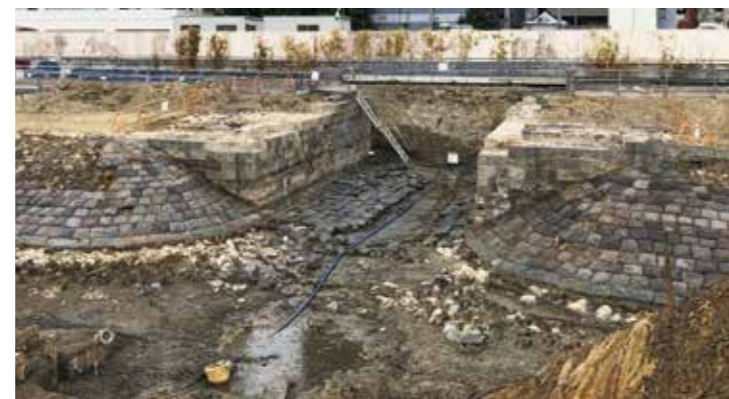
今回出土した高輪築堤の、水路のための橋台部分。
