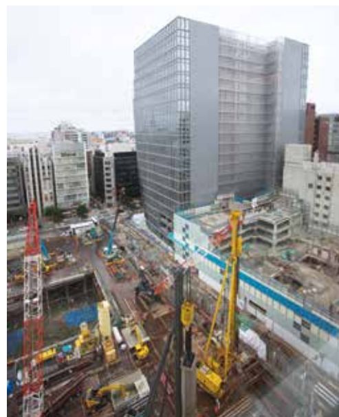
天神ビジネスセンター周辺でも、新たなビルの建設が相次ぐ。
