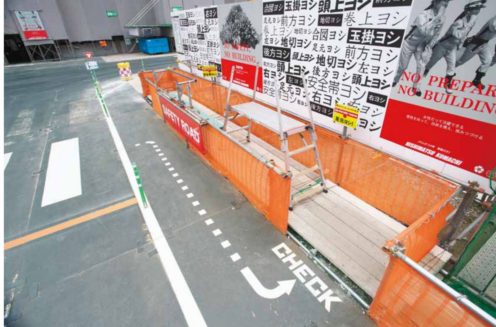
現場に入場する全員が通る「SAFETY ROAD」。作業台の上を通ったり安全帯を確認したりして、健康状態と装備を効率的にチェックする。
