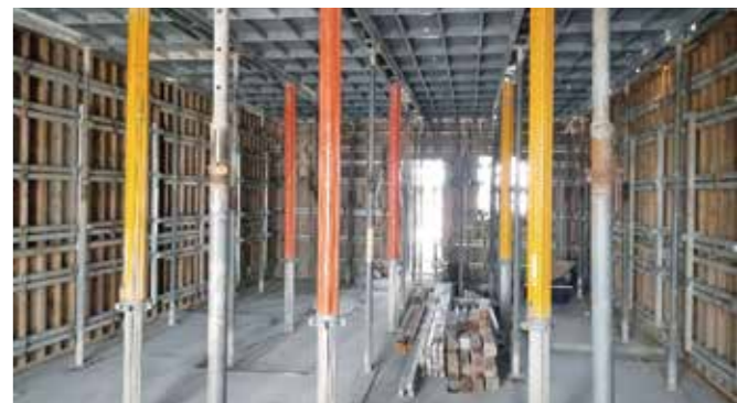
アルミ製のシステム型枠を使用した下階の状況。存置中、通常より少ない支保工で支えられる。(提供:西松建設株)
