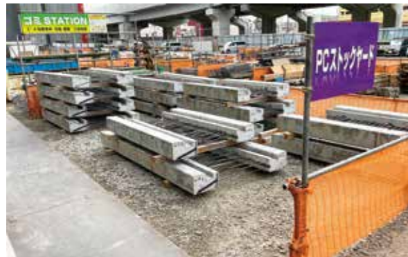
広大なヤードを生かし、バルコニーなどの複雑な形状の部材をプレキャスト(PC)化して地上で製作した。上の写真は転用に有利な鋼製のシステム型枠、下は脱型した部材のストックだ。(いずれも提供:西松建設株)
