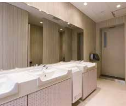
従業員用トイレの表面材は抗ウイルスメラミン樹脂を採用した。
