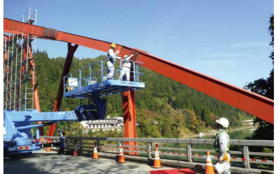
橋の最高地点は19mもの高さがあるため、まずは高所作業車を使い、ボルトが抜け落ちた箇所を探した。その後、劣化した塗装を削って、新しいボルトを取り付けた。
