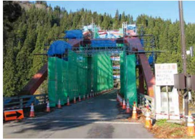
上／高所作業車での作業後は、足場を組み、古いボルトすべてを新しいものに交換した。
