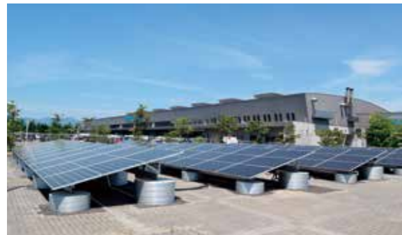
上/郡山市総合地方卸売市場内のHydro Q-BiC 下/Hydro Q-BiCに隣接している太陽光発電パネル
