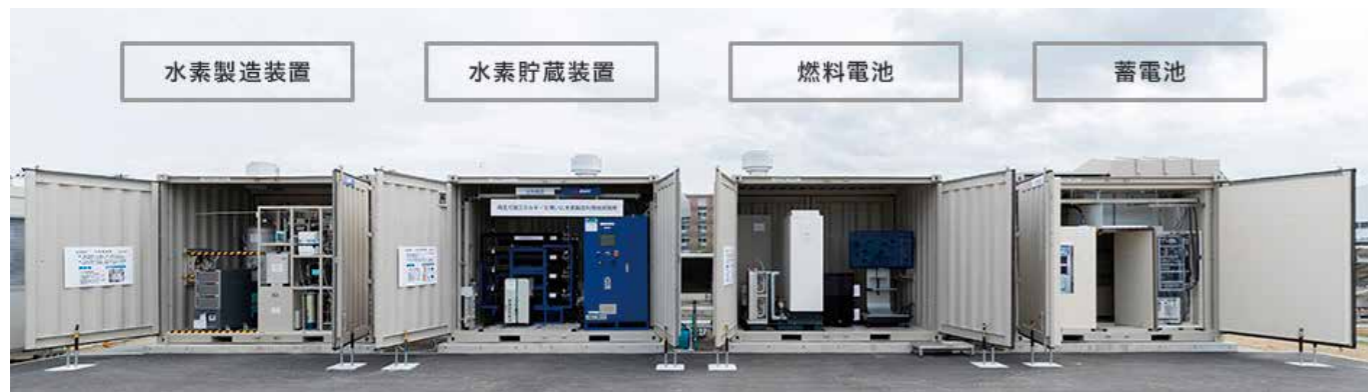
FREA内に建設された水素エネルギー利用システム「Hydro Q-BiC」
