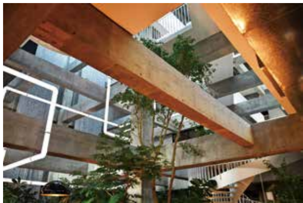
4階までの壁と床を抜いた白井屋ホテルの吹き抜け
