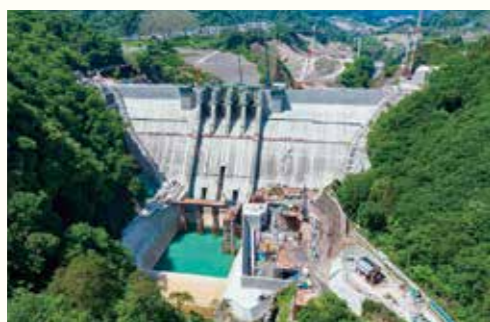
第1回土木賞受賞 八ッ場ダム本体建設工事
