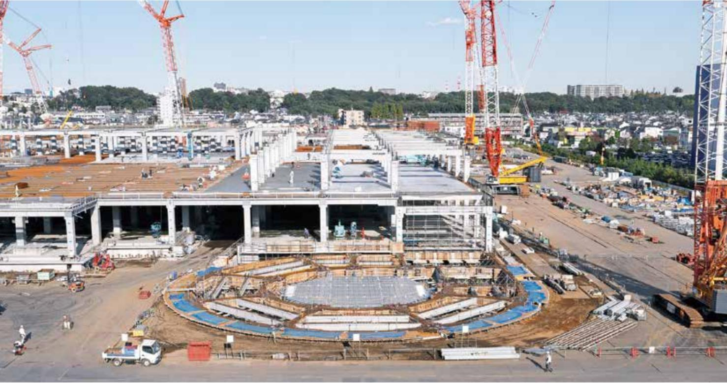
PC部材をクレーンが次々と揚重し、効率的に組み立てていく。トラックが昇降する螺旋形のランプウェイも、部材製作の技術が進化したことによりPC工法が可能となった
