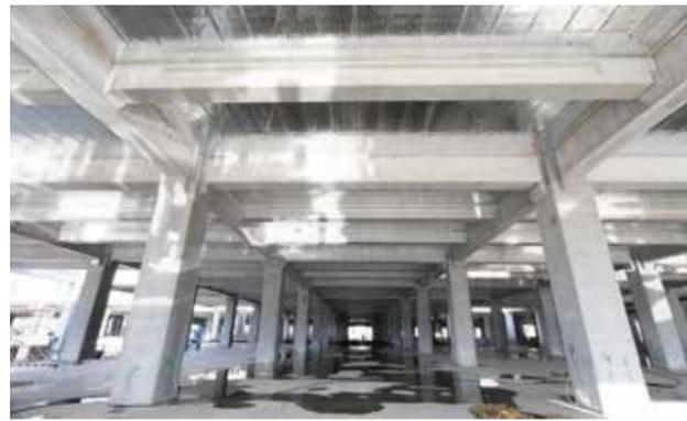
PC部材を用いて免震構造、RC造を採用した倉庫の耐用年数は200年と試算される。強固な構造が資産価値を高め、将来的に多様なニーズへの対応も可能とする
