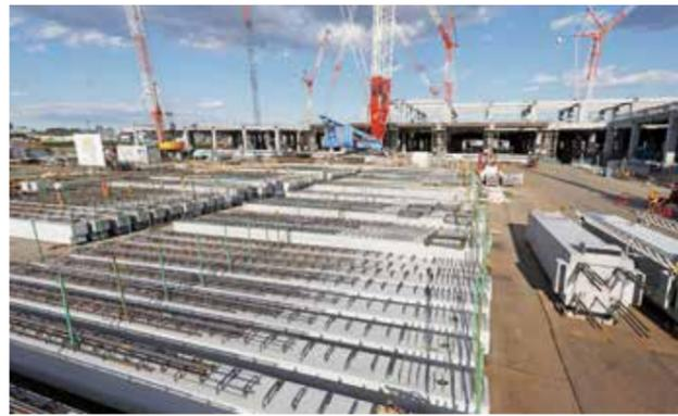
ヤード内のPC部材。巨大かつシンプルな建造物の建築には、現地で極力人の手を介在させない工夫を凝らすことが生産性の向上に直結する
