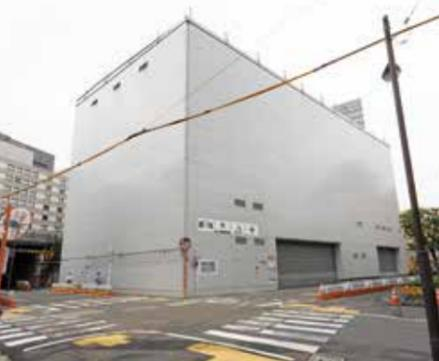
千代田区飯田橋に建設された防音ハウス。狭い敷地内に作業スペースを確保するため、地上21.3mもの高さがある。
