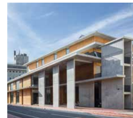
北東側から望む外観
