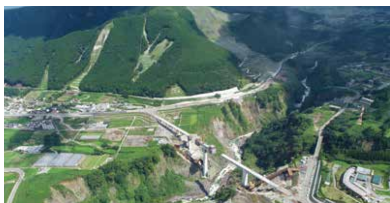
熊本地震からの早期復興の切り札となる阿蘇大橋の架け替え工事 (提供:大成建設株)
