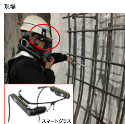
接触機会を避けるため導入が進む遠隔現場システム (提供：五洋建設株)
