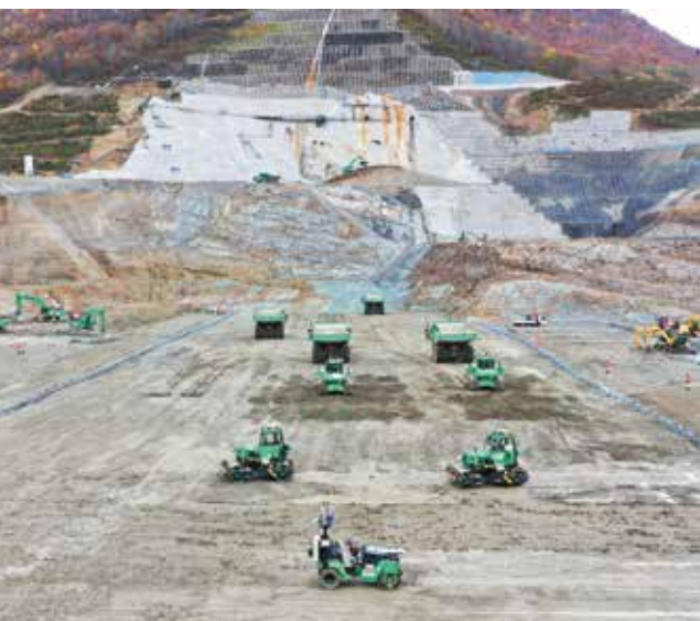
ダム工事現場における自動化施工 (提供:鹿島建設株)
