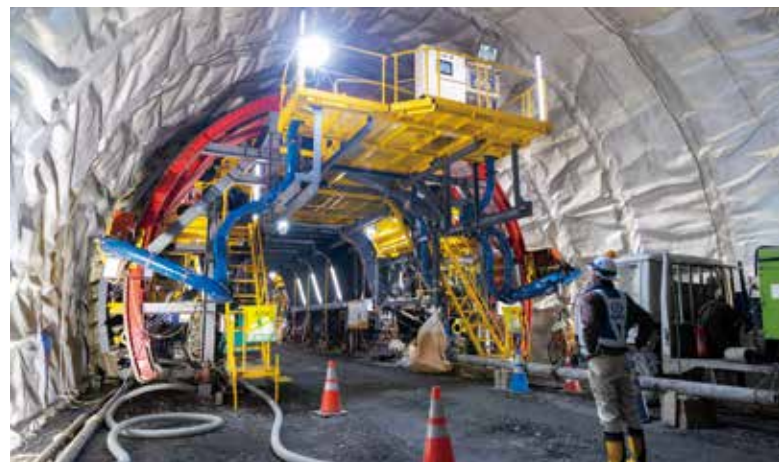
省人化を徹底し、生産性を向上した覆工コンクリート自動打設システム (提供: 清水建設㈱)
