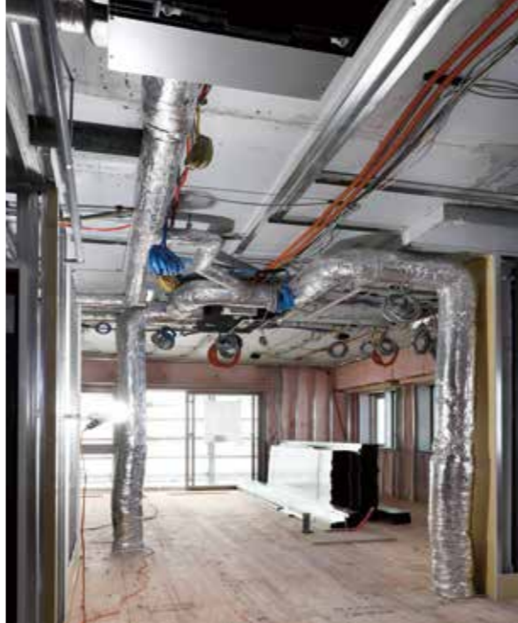
上/一部住戸の窓には二重サッシを採用 左/天井裏に配置されるエアコンからダクトを床下まで配管する
