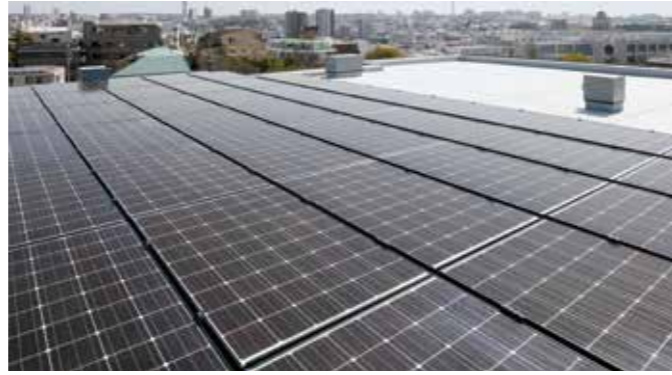
屋上には可能な限り太陽光パネルを設置した。東側（左の写真右側）には最上階住戸のルーフバルコニーがあり、室内への反射光を可能な限り遮り、景観を維持するためにパネルの設置を避けた。各パネルは住戸の広さに応じて12戸ごとに割り振られている（いずれも提供：株式会社鴻池組）
