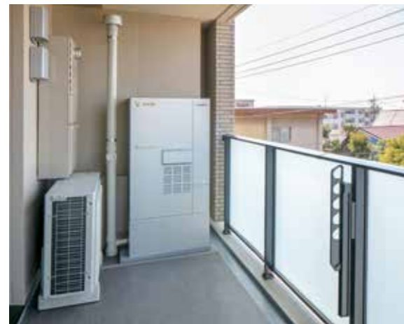
上／バルコニーに設定されたエネファーム 右／高断熱浴槽を採用したバスルーム (いずれも提供：積水ハウス株)
