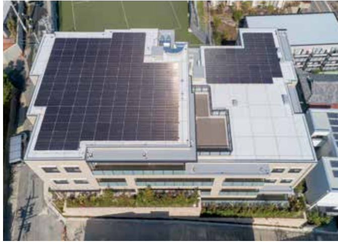
屋上には可能な限り太陽光パネルを設置した。東側（左の写真右側）には最上階住戸のルーフバルコニーがあり、室内への反射光を可能な限り遮り、景観を維持するためにパネルの設置を避けた。各パネルは住戸の広さに応じて12戸ごとに割り振られている（いずれも提供：株式会社鴻池組）
