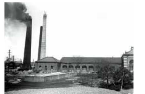
1925(大正14)年撮影、バルトンが主任として調査を行った淀橋浄水場の蒸気ポンプの煙突。レンガ造りの黒い煙突(後に解体)と鉄筋コンクリートの白い煙突が並ぶ。(提供:東京都水道歴史館)
