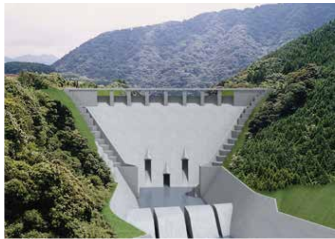
景観設計にCIMモデルを用いて現況と施工後と比較。阿蘇の風景と調和するシンプルなダムの景観創出を目指した。（提供：国土交通省九州地方整備局立野ダム工事事務所）
