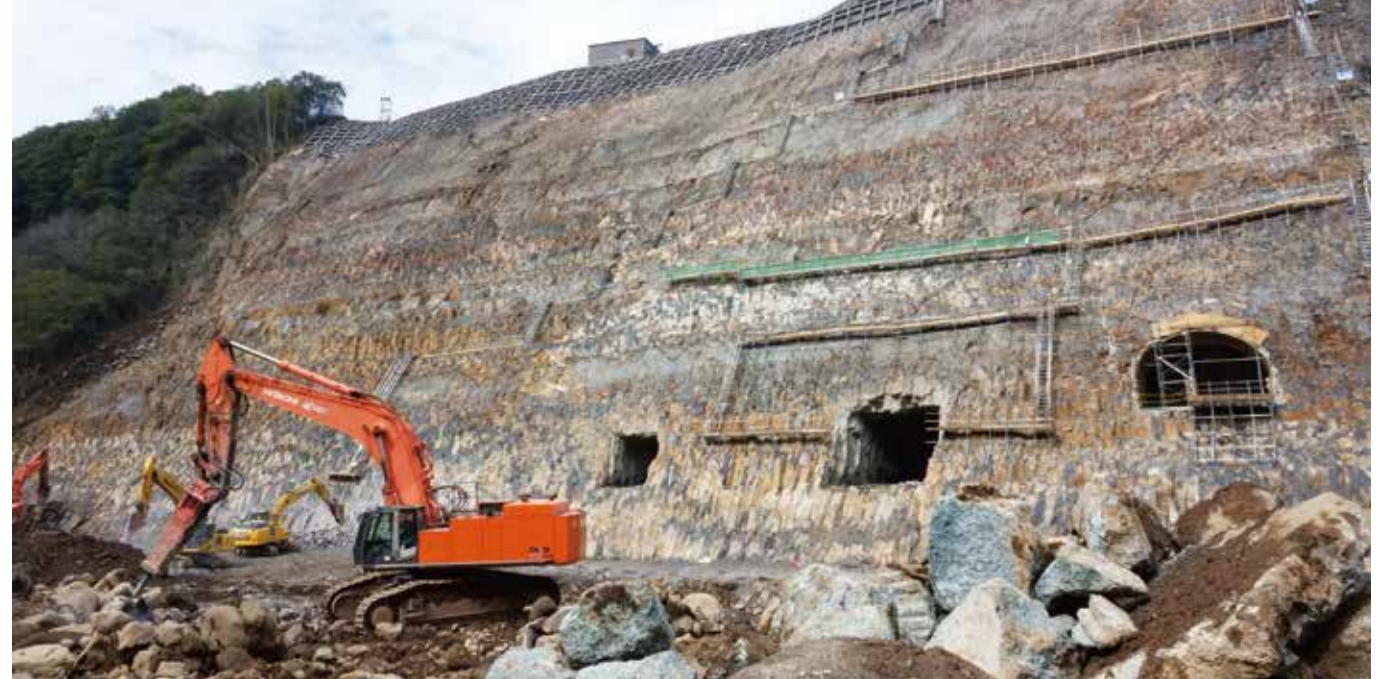
現場では着々と基礎掘削工事が進む。法面には調査杭やグラウチングを行うトンネルが穿たれている。
