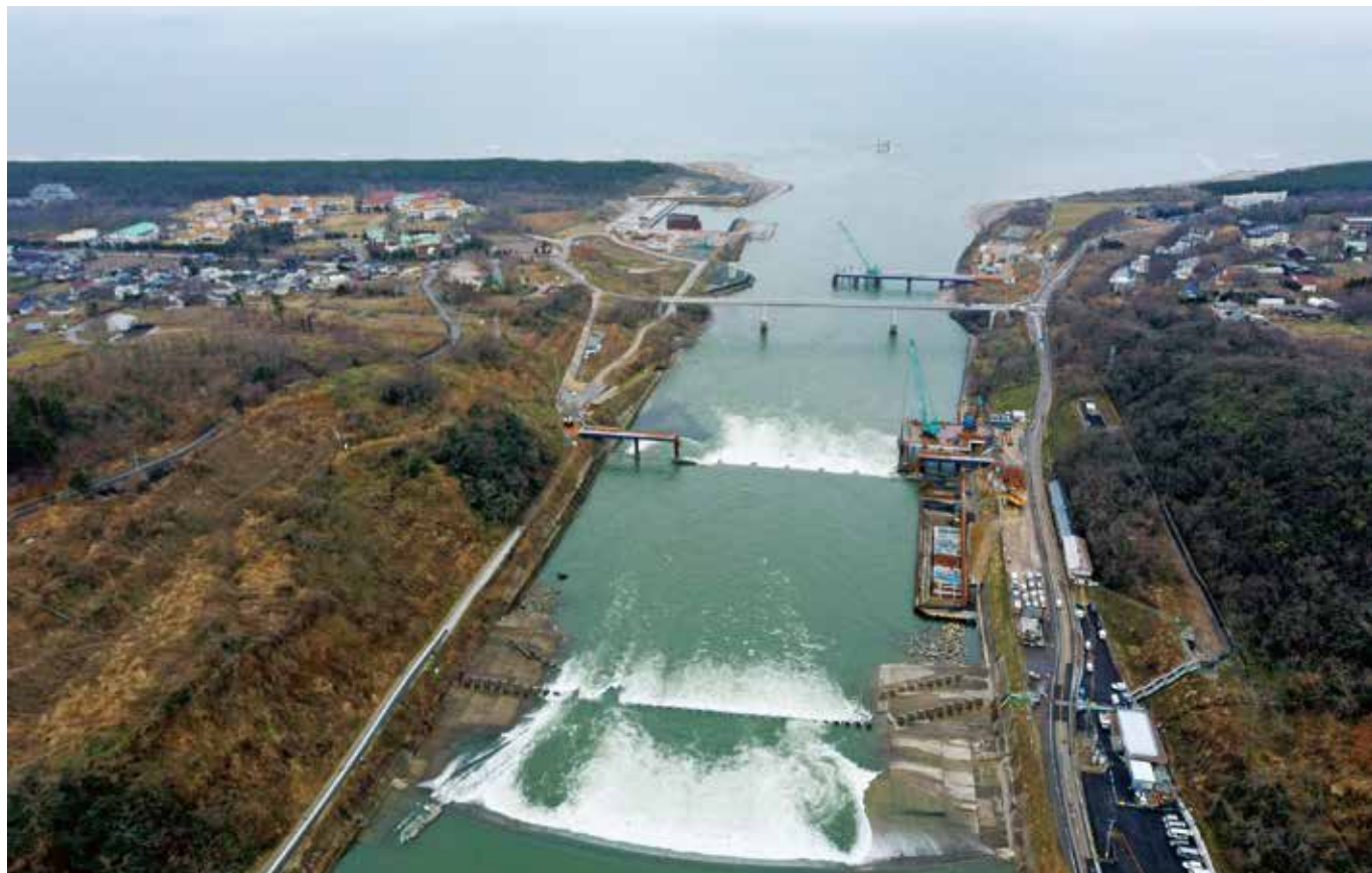
日本海に注ぐ大河津分水路、河口部に第二床固の基礎となる鋼殻が仮置きされていた。その鋼殻を写真中央の現場まで曳航、設置する。
