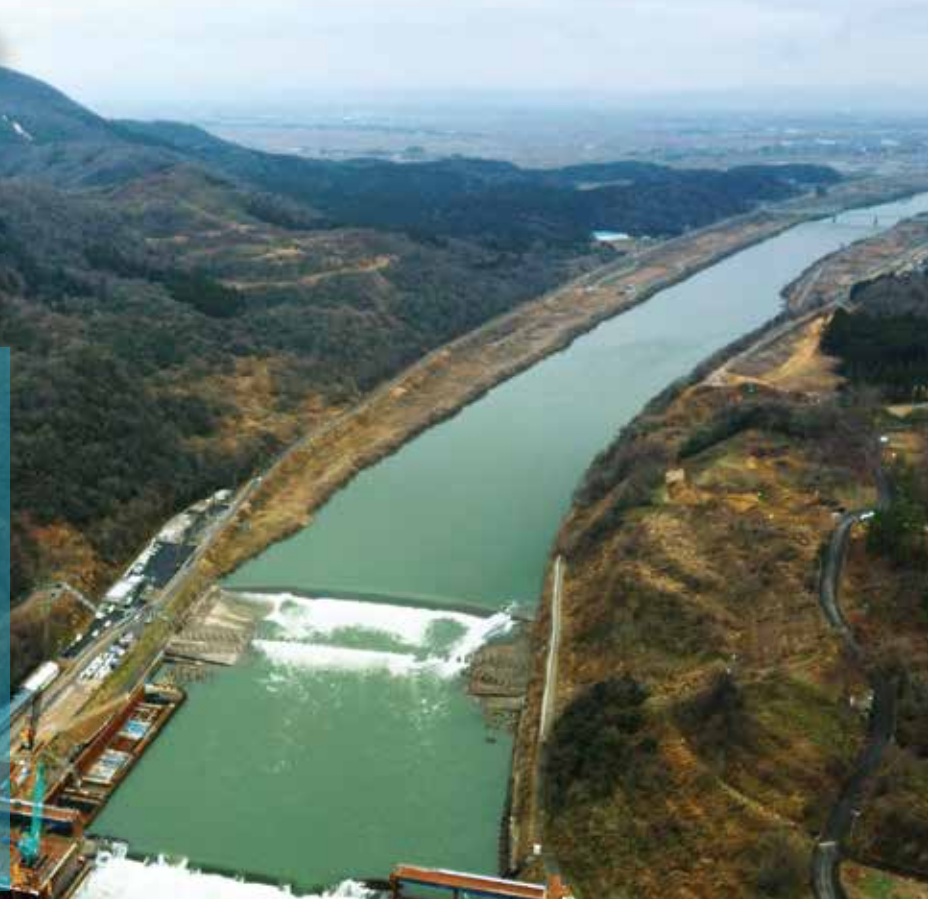
第二床固の新設工事が進む大河津分水路河口部。
