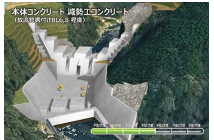
ダム本体の施工ステップを動画に加工した。時系列的に景観の変化を確認できる。（提供：国土交通省九州地方整備局立野ダム工事事務所）
