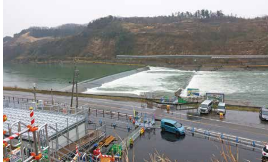
現在の第二床固。新設された後撤去される。隣接して建設中の新たな見学施設でもBIM／CIMが活用されている。
