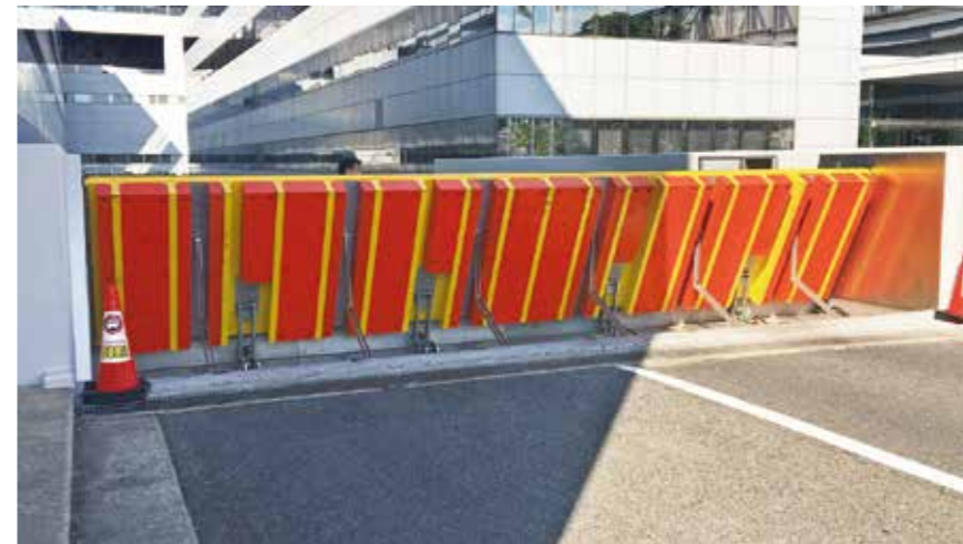
地下エリアへの浸水を防止する止水板を設置。(提供:関西エアポート株)
