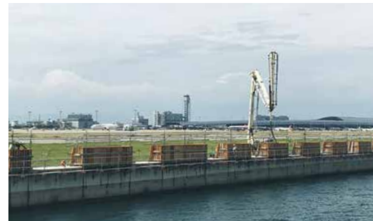
動力源となる電気設備も移動電源車の導入、排水制御盤、受配電施設のシェルター化を行ない、万全を期す。護岸の嵩上げも進められている。(提供:関西エアポート株)
