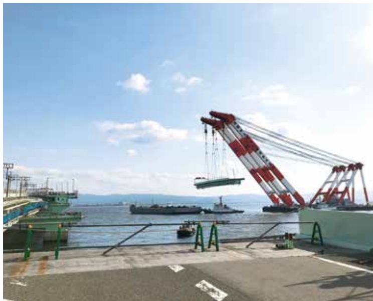
関西国際空港と対岸を結ぶ空港連絡橋にタンカーが衝突し、空港は孤立した。「こうした事態」にならずとも、何らかの原因で通行不能になる可能性もあることを「想定」する必要があるという。連絡橋の復旧には7カ月を要した。左は復旧工事の様子、上は取材時(2019年12月下旬)に撮影した連絡橋の様子。(左の写真提供:関西エアポート株)
