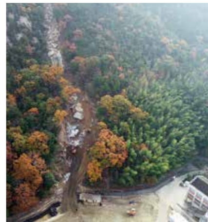
②応急対策を実施中
