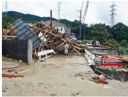
大谷川では流木で橋が閉塞(広島市東区馬木町)
