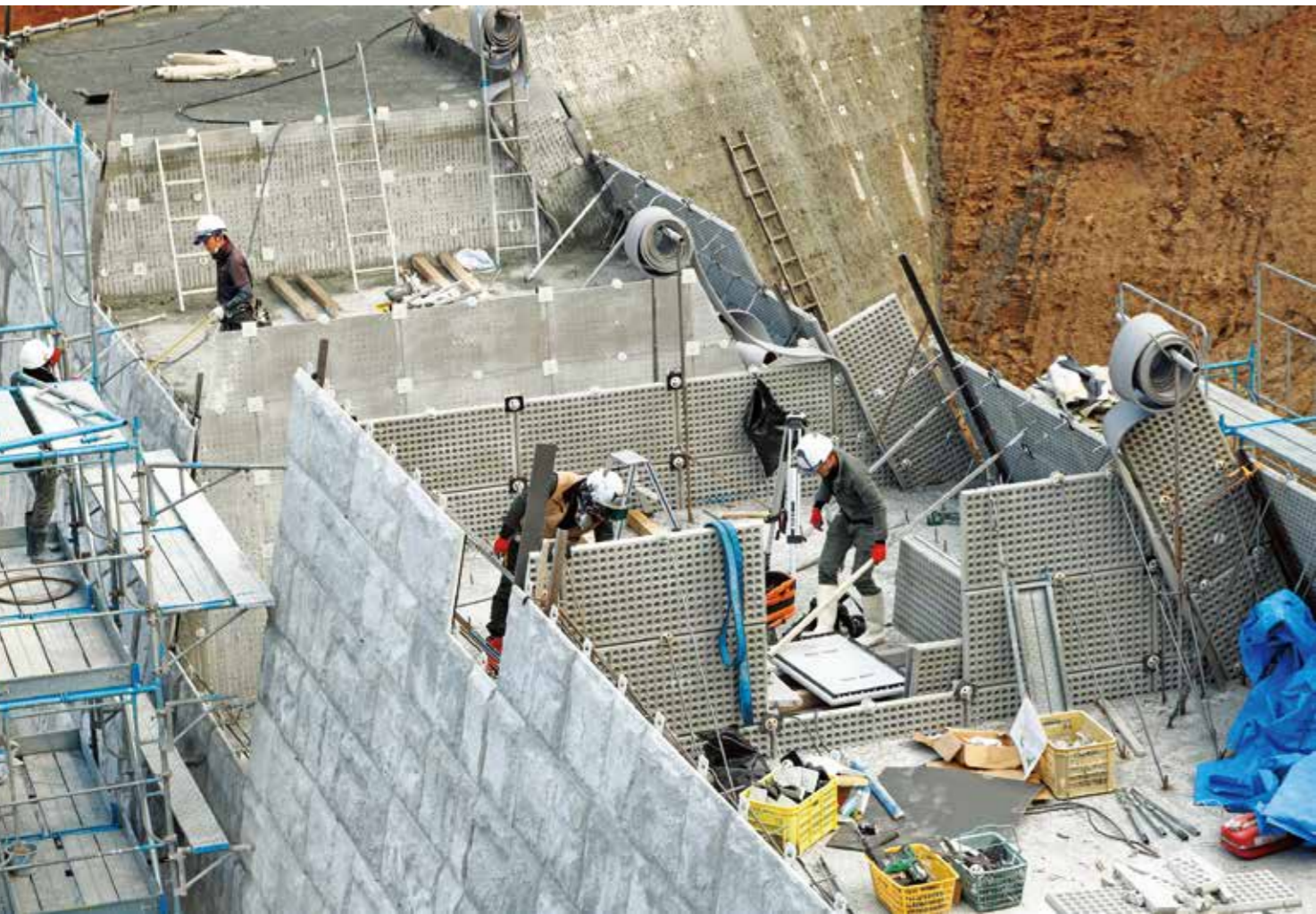
堰堤本体は、堰堤施工ではスタンダードになりつつある残存型枠工法を採用。薄肉コンクリート製型枠で外壁を構築して内側からコンクリートを打設するため、高所における打設、脱型作業が不要となり、安全性が向上する。
