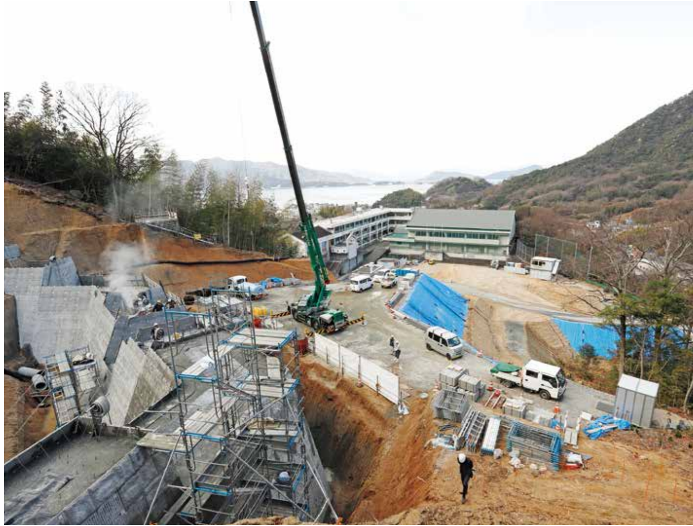
砂防堰堤の現場は中学校校庭の正面に展開する。その海側は市街地だ。土砂災害から町を護る堰堤の構築が着々と進んでいる。
