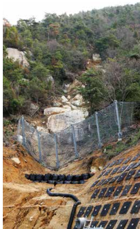
露出した岩をワイヤーで押さえ、更に鋼製のネットで万が一の落石に備える。安全を確保したうえで本体の施工に着手した。現場内には多数のセンサーを配置し、回避訓練も日常的に行っている。
