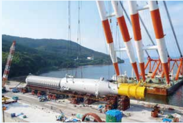
①岸壁で工場製作した鋼製の上部浮体とコンクリート製の下部浮体を接合する
