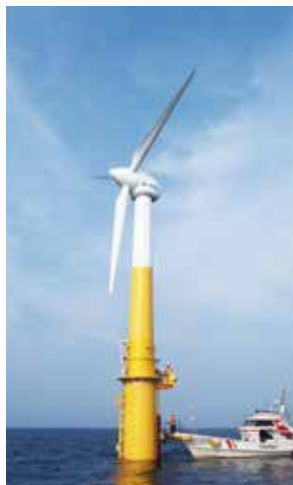
戸田建設が2009年に初の実海域実験を行った際の1/10スケールの試験機（左）。2012年の1/2スケール、100kWの小規模試験機（右）は系統連系した国内初の浮体式洋上風力発電施設となった。（いずれも提供：戸田建設株）
