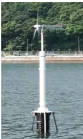
戸田建設が2009年に初の実海域実験を行った際の1/10スケールの試験機（左）。2012年の1/2スケール、100kWの小規模試験機（右）は系統連系した国内初の浮体式洋上風力発電施設となった。（いずれも提供：戸田建設株）
