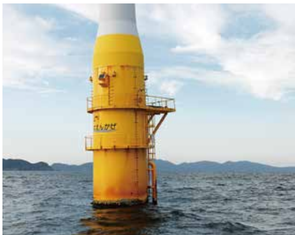
戸田建設が2009年に初の実海域実験を行った際の1/10スケールの試験機（左）。2012年の1/2スケール、100kWの小規模試験機（右）は系統連系した国内初の浮体式洋上風力発電施設となった。（いずれも提供：戸田建設株）
