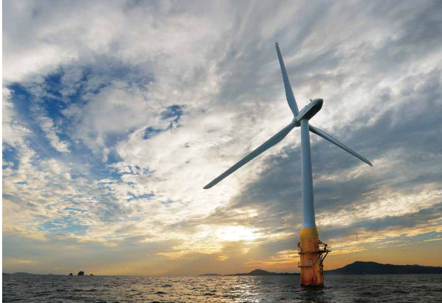
写真右手から風を受ける「はえんかぜ」。風車のタワーは、ブレードが最大の風量を受けるよう海面に対し垂直を維持するよう傾斜する。浮体式風車の大きなメリットの1つだ。
