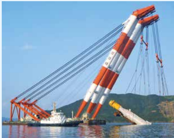
③大型起重機船で浮体を洋上に建て起こす
