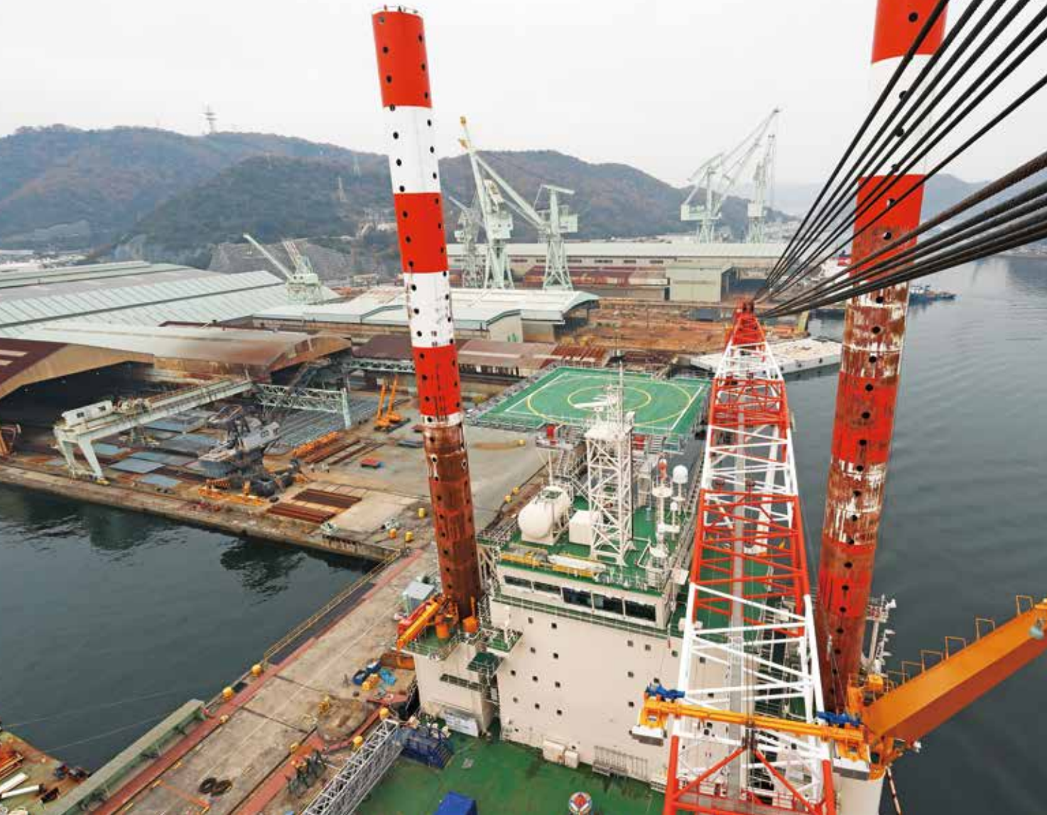
クレーン施設からCP-8001の全景を望む。この巨大クレーン、ヘリポート、デッキ部の部材も詳細に検討し、軽量化を図った。
