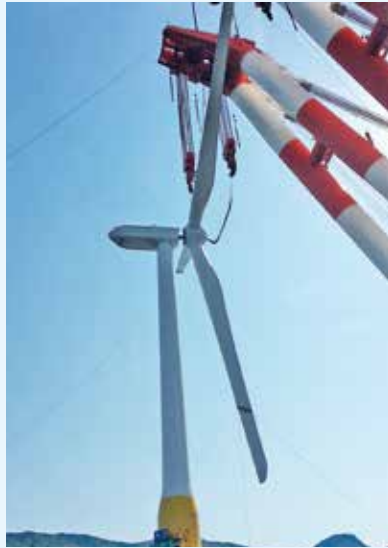
④浮体部に設備を艀装して風車完成 (いずれも提供：戸田建設(株))
