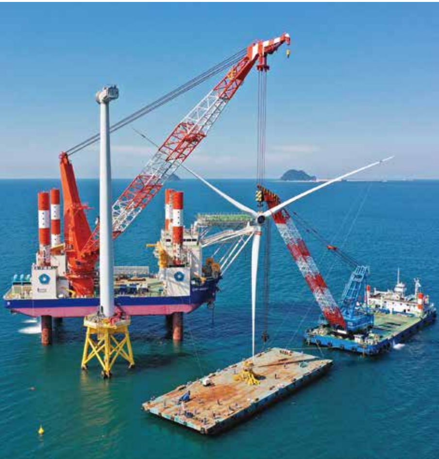
響灘の実証施設撤去作業。(提供:五洋建設株)
