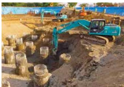
ICT建機での施工の様子。誤差10cm以下で掘削ができたため、鉄筋を防護するコンクリートが不要だった。(提供:株鴻池組)
